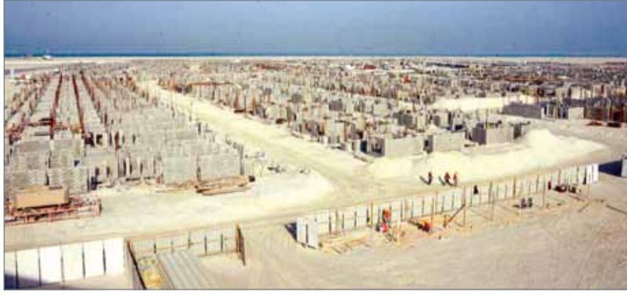
• مراحل البناء والإنشاء بوتيرة منتظمة حسب الجدول الزمني الممد لما
