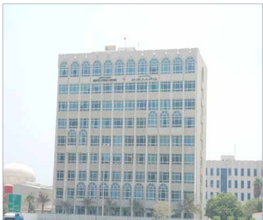
• مبنى وزارة الأشغال
