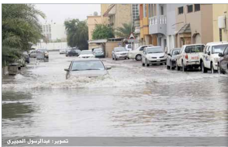
• هكذا بدت بعض المناطق بتجمع مياه الأمطار بسبب سوء البنية التحتية
