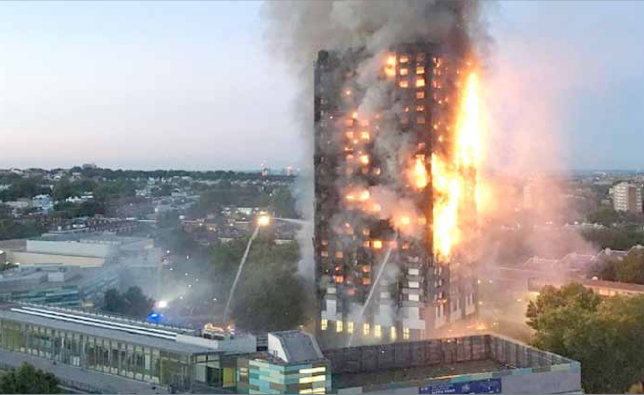
• حريق برج غرينفل غربي لندن
