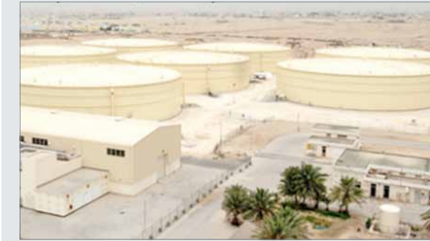
محطة مدينة حمد لخلط المياه
