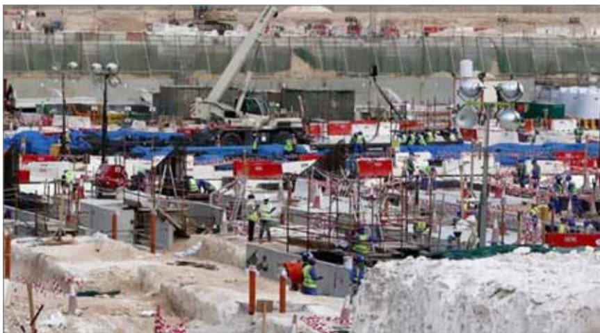
• جانب من أعمال البناء في ملعب الوكرة المخصص لاستضافة كأس العالم 2022
