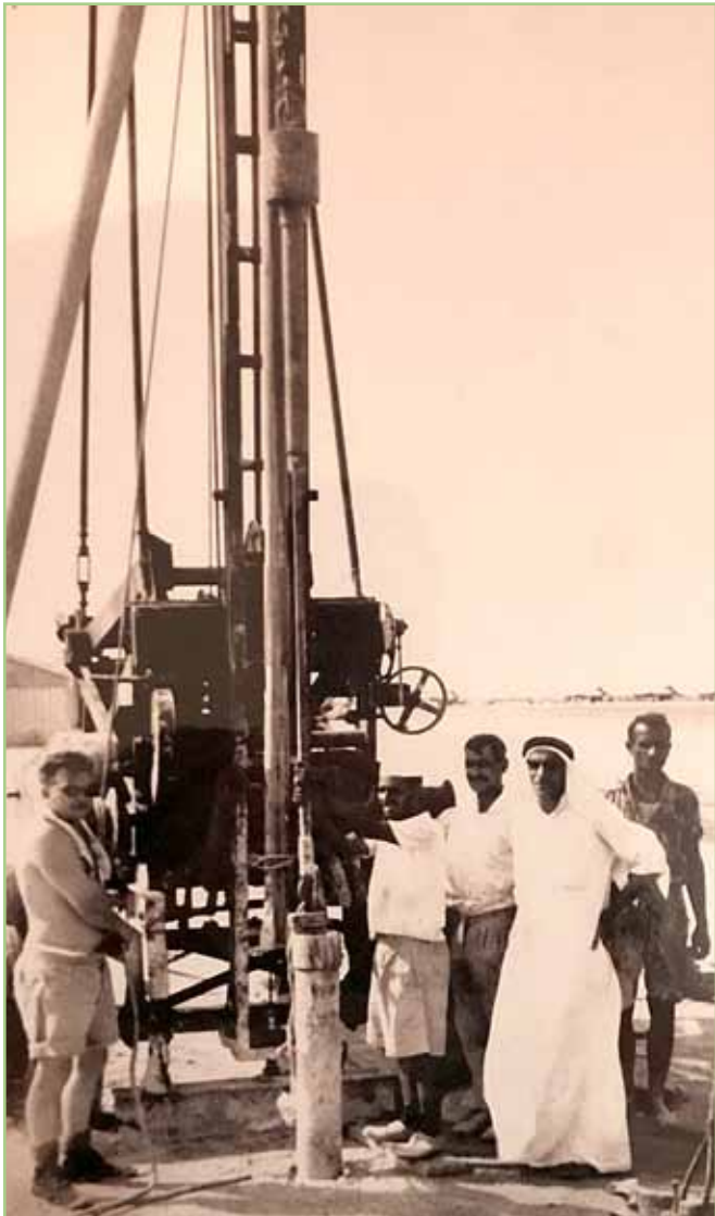
● إنجنير خلال إحدى عمليات حفر المياه
