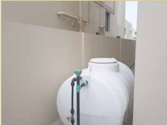
خزان المياه يقطع الطريق بجانب المنزل
