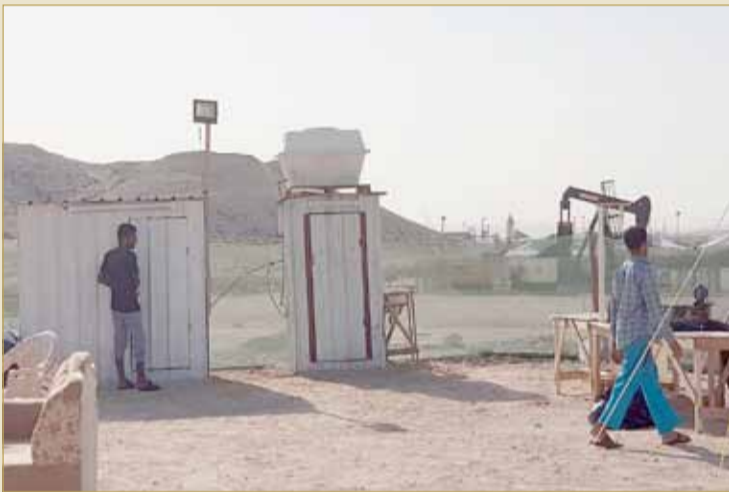
عمال أتهوا العمل في تجهيز دورات المياه
