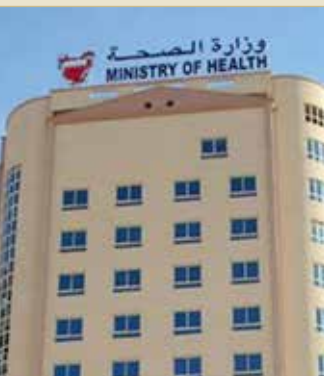
مبنى وزارة الصحة
