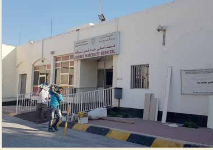
جانب من أعمال الصيانة
