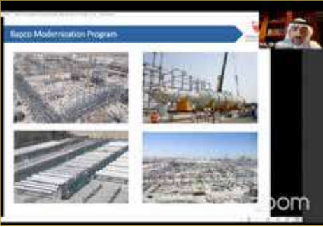
مشروع تحديث مصفاة بابكو
