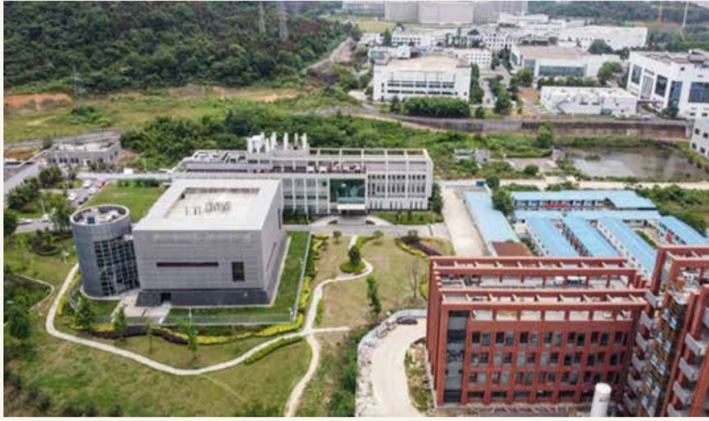
صورة جوية لمختبر "بي 4" في المعهد الصيني لدراسة الفيروسات في ووهان (أ ف ب)
