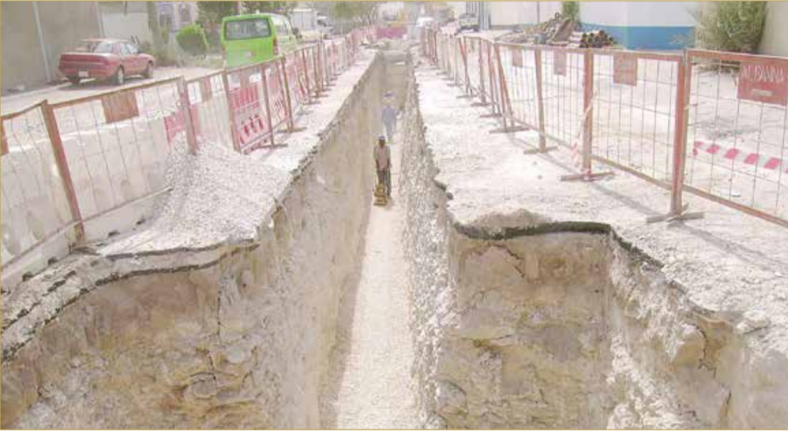
جانب من إحدى أعمال شبكات الصرف الصحي
