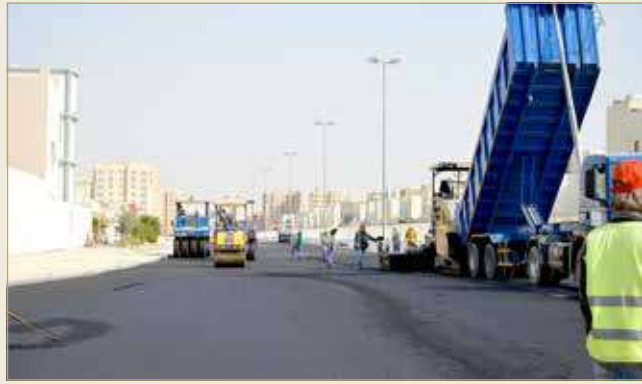
أعمال مشروع الطرق المؤدية إلى اللوزي
