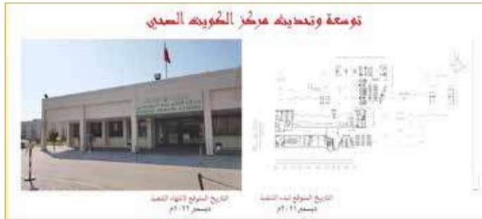
مشروع توسعة وتحديث مركز الكويت الصحي
