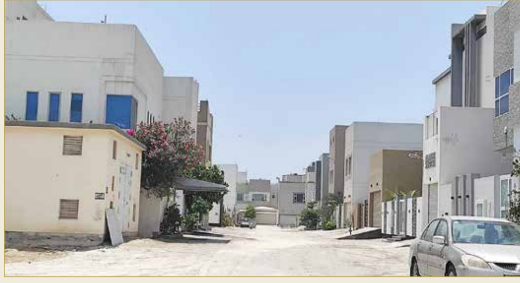
أحد أحياء ريا والفردوس التي تنتظر توصيلها بالصرف الصحي
