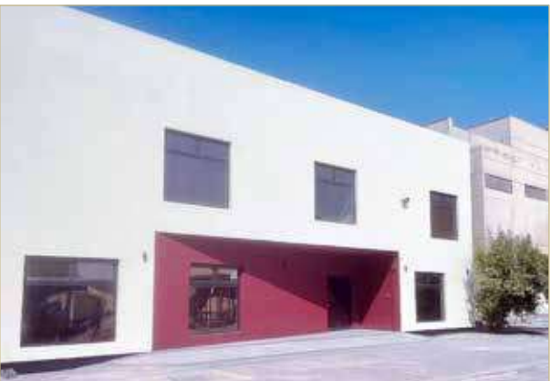
تأهيل مبنى الهندسة الكيميائية S3
