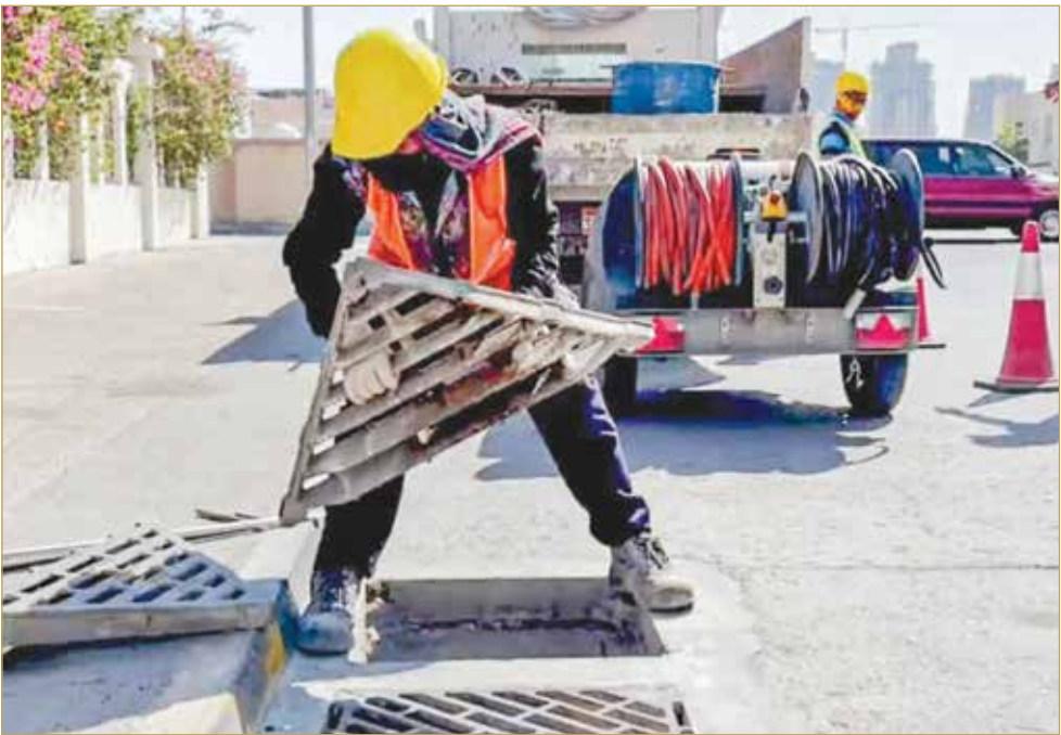
تنظيف فتحات تصريف المياه
