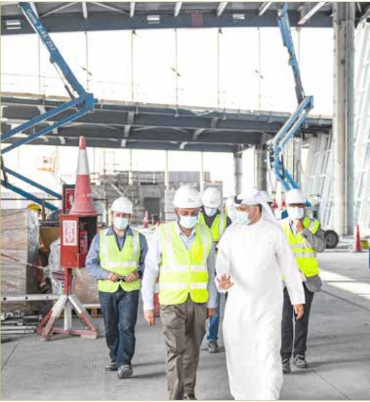
الوزير كمال متفقدًا أعمال مبنى المسافرين الجديد
