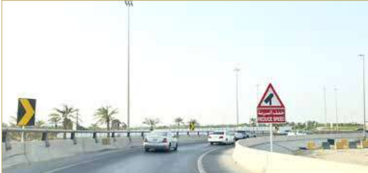
تقاطع الجسرة (منحدر رقم 1)
