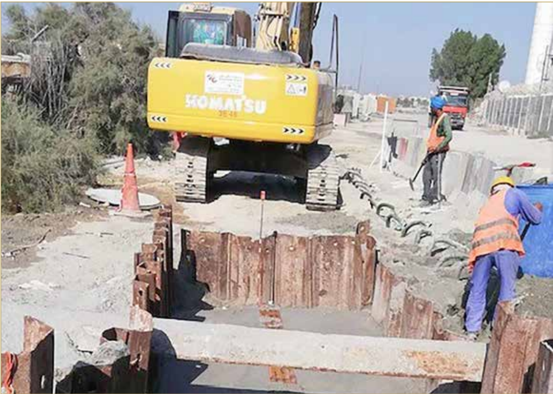
أعمال توصيل شبكات الصرف الصحي في عالي
