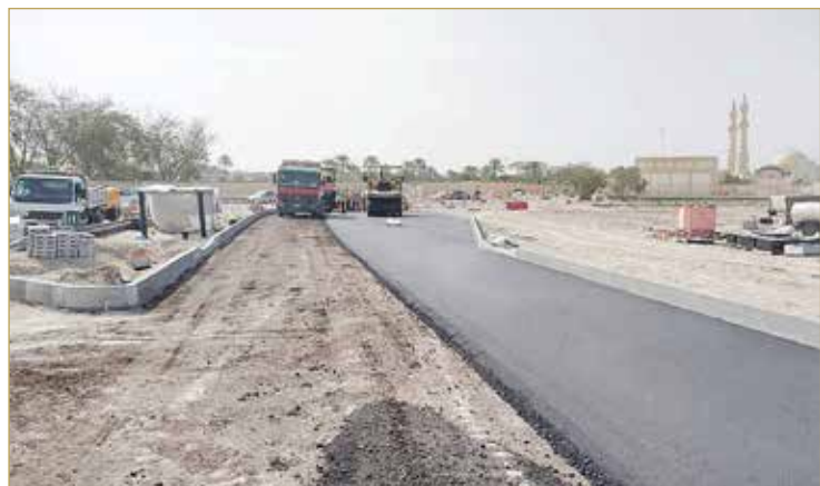
جانب من أعمال رصف الطرق في سار
