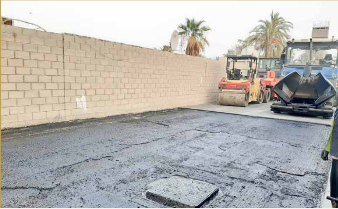
أعمال تطوير الطرق الداخلية في جنوسان
