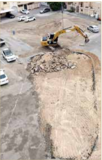
البناء بموقع الأرض
