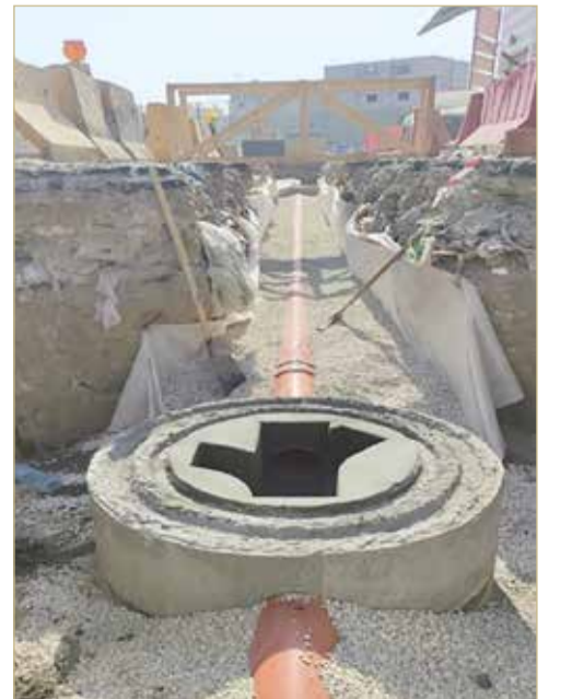
من أعمال التمديدات لشبكة الصرف الصحي بمجمع 1205
