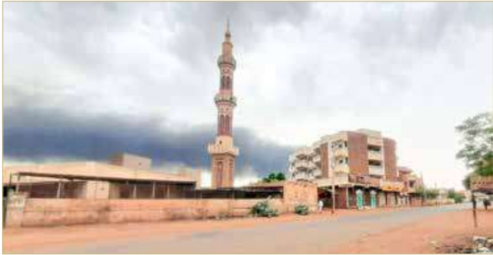
دخان يتصاعد فوق المباني الواقعة خلف شارع شبه مهجور في الخرطوم
