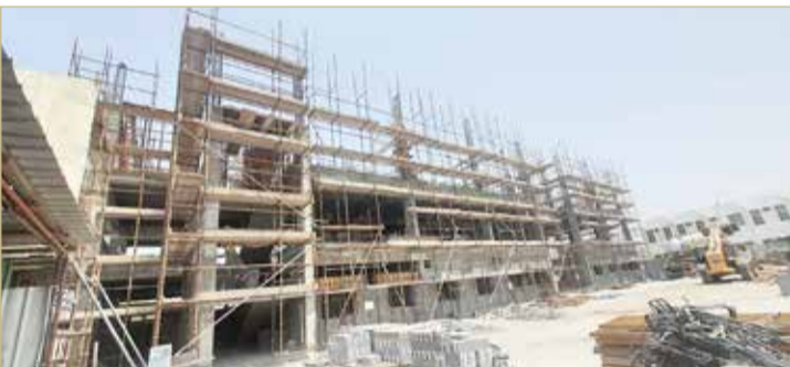
العمل على تنفيذ أعمال الهيكل الخرساني والأعمال الكهروميكانيكية
