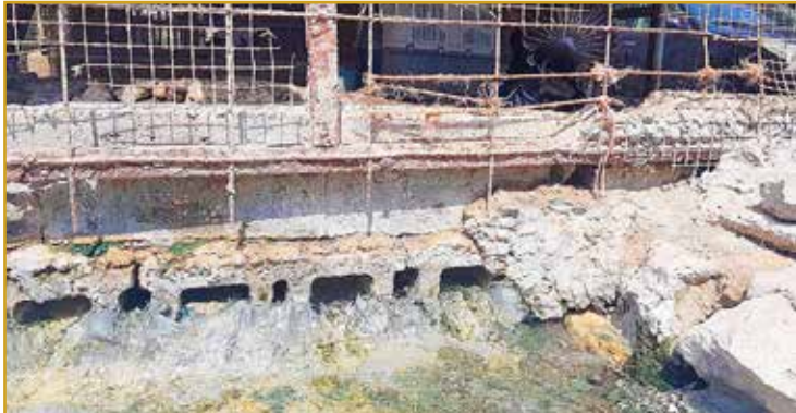
توفير المياه الباردة لتخميم الحيوانات وشرربها
