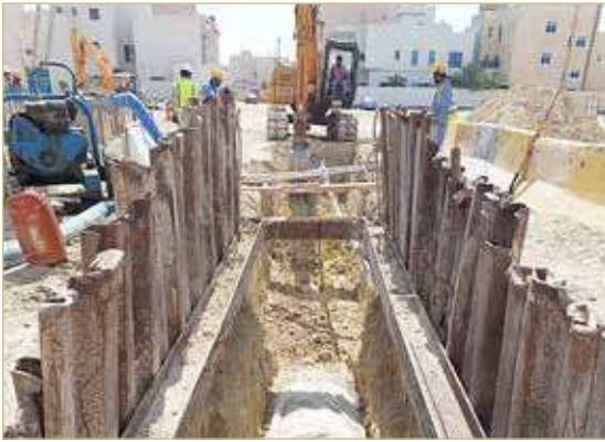
تغطية خطوط الصرف الصحي تمهيدا لبدء أعمال الدفان بمجمع 604 بستره
