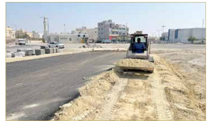
أعمال مشروع تطوير طريق 2823 وشارع الشيخ دعيج في الساية
