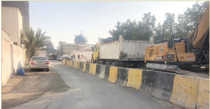
جانب من أعمال المشروع
