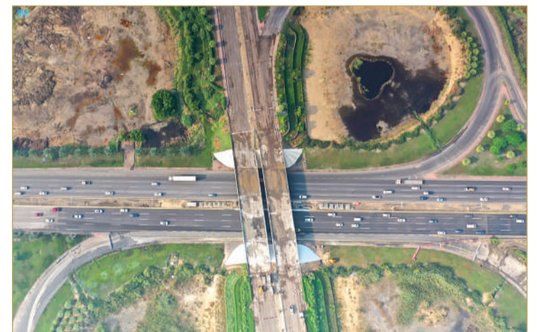
تنتظر المنطقة الشرقية حراكًا كبيرًا على مستوى شبكة الطرق
