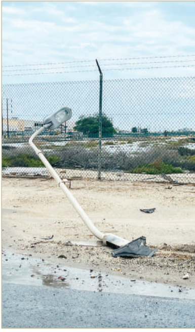
سقوط عمود إنارة في منطقة سلماباد
