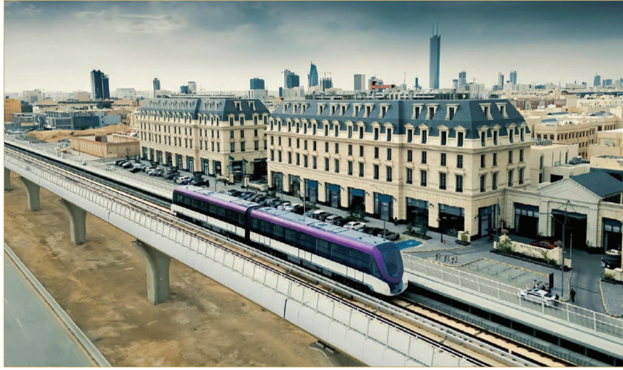
مشروع مترو الرياض
