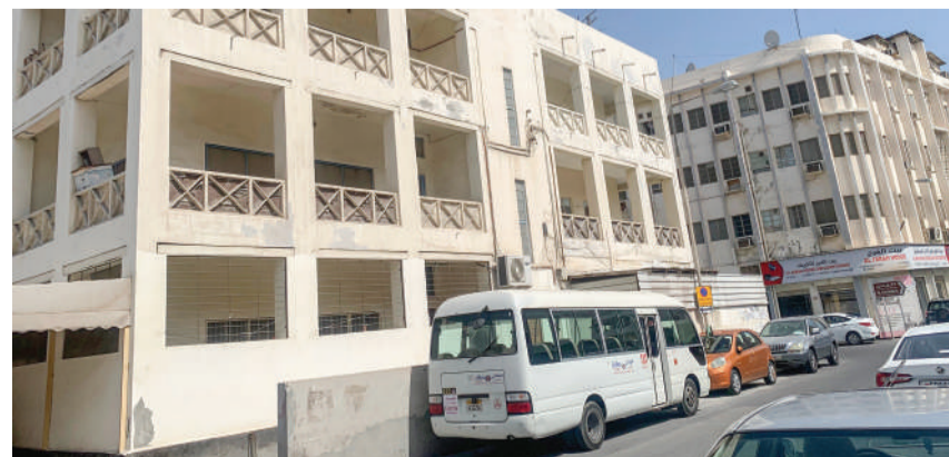
بعض المباني القريبة من القصر والقائمة حتى لان احتفظت ببعض ملامح هندسة قصر عرشي
