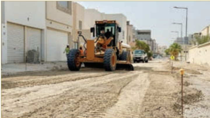
أعمال مشروع الصرف الصحي في اللوزي ومدينة حمد
