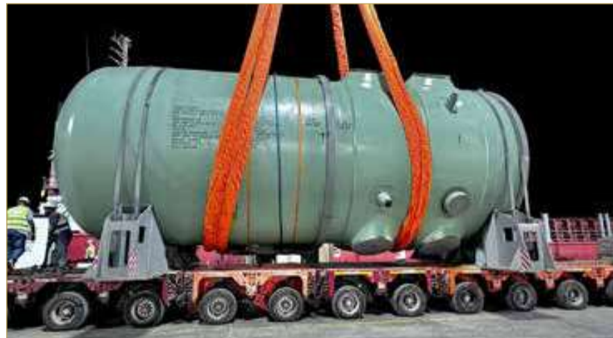
بدء أعمال تركيب وعاء ضغط المفاعل في نوفمبر
