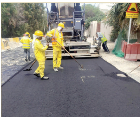
بالإضافة إلى إنشاء خطوط صرف صحي رئيسة بطريقة الحفر المفتوح، وخطوط صرف
