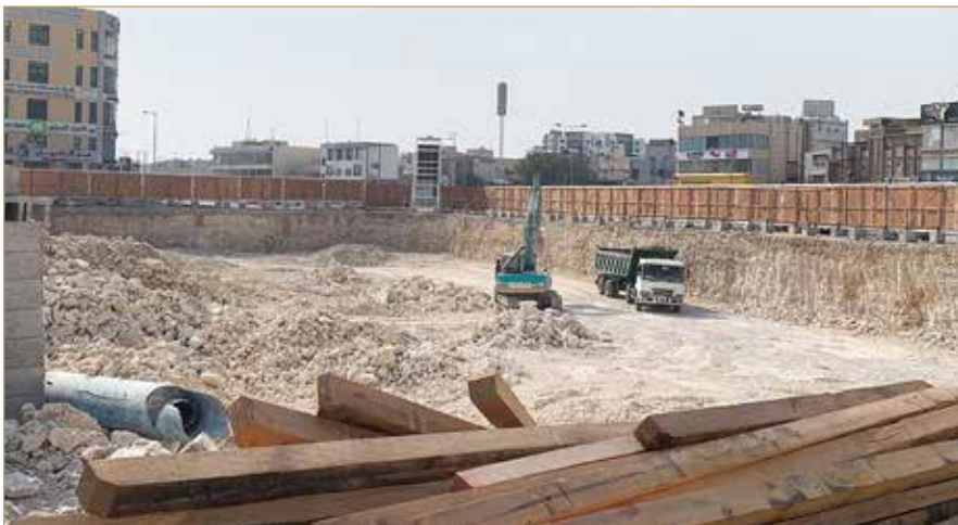
أعمال في موقع مجمع تجاري
