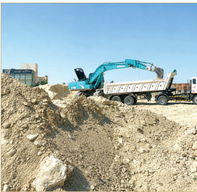
نقل الرمال وتهيئة الأرض للردم بالصخور
