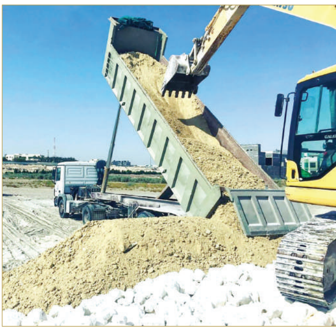
جانب من أعمال الإنشاءات
